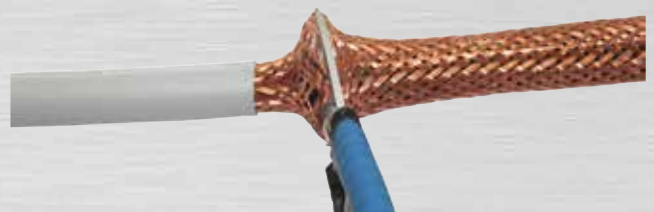
Bild 13: Durchtrennen des Schirmgeflechtes
