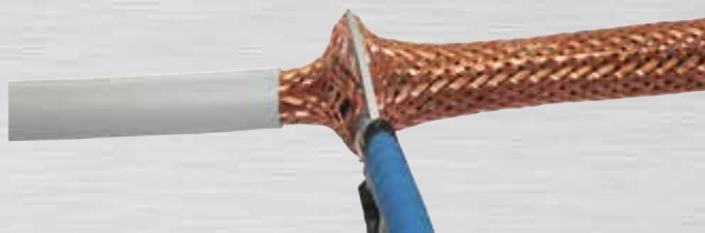
Bild 93: Durchtrennen des Schirmgeflechtes
