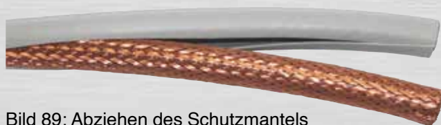
Bild 89: Abziehen des Schutzmantels
