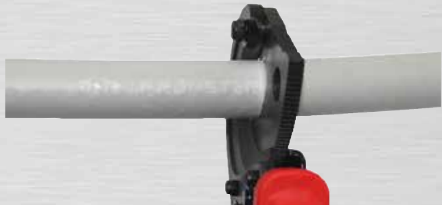
Bild 82: Ablängen der Leitung
