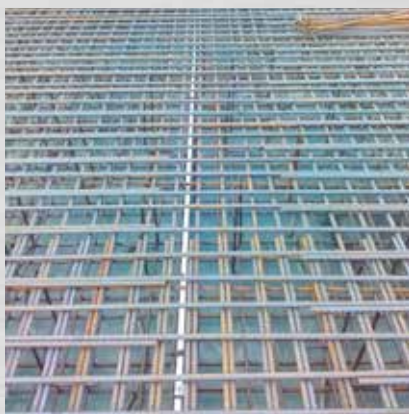
Praxisbilder 1-3: Fundamenterder bzw. kombinierte Potentialausgleichsanlage
