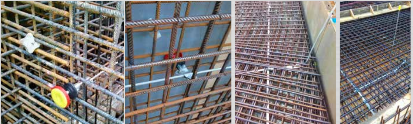
Praxisbilder 6-9: Erdungsfestpunkte und Anschlussfahnen
