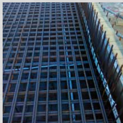
Praxisbilder 1-3: Fundamenterder bzw. kombinierte Potentialausgleichsanlage
